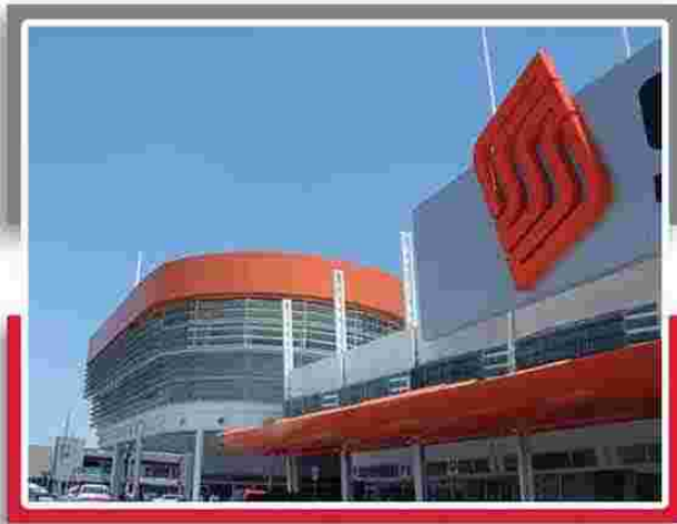
Proyecto: Soriana Ubicación: Monterrey, N.L. 2004
